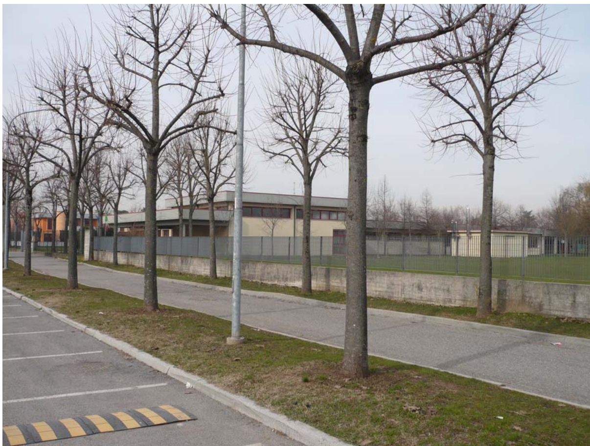
Figura 2.2-5: complesso scolastico visto da Via Tavini
